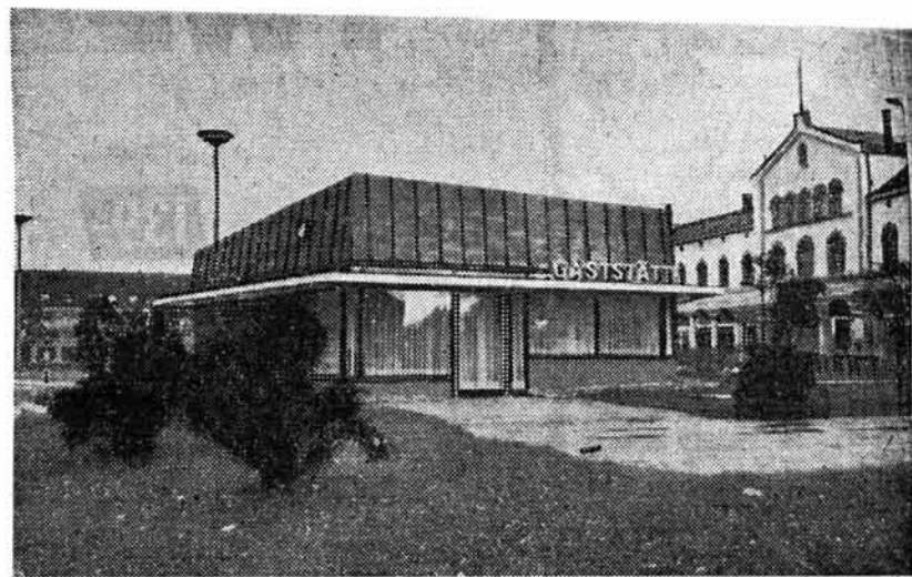
So sieht die „Park-Gaststätte“ vom Westen her aus. Rechts im Hintergrund sind die Stahlträger des Bahnhofvordaches zu sehen, das neben einigen anderen kleineren Arbeiten erst in den nächsten Wochen fertig wird.
